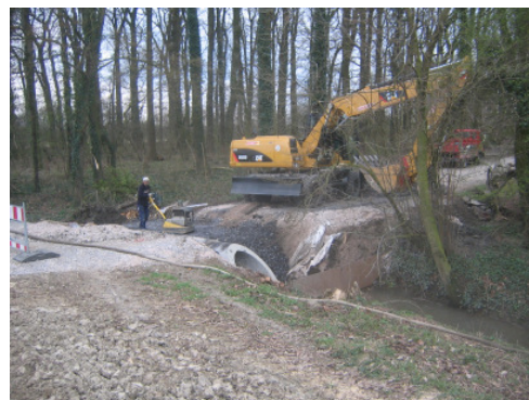
Bönen Bau einer Grabenverrohrung
