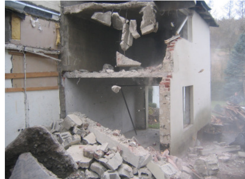
Hagen Teilabbruch für Neubau
